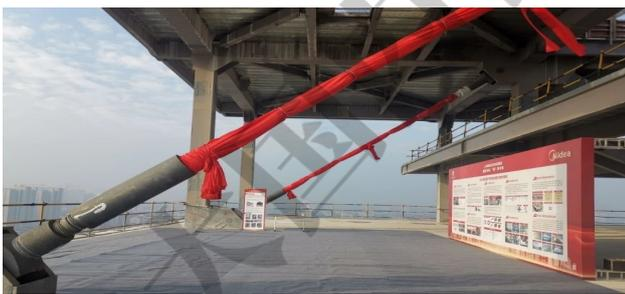
碳纤维复合材料桥梁拉索工程示范应用
