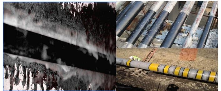
碳纤维复材加固沪宁图结构与油田管道
