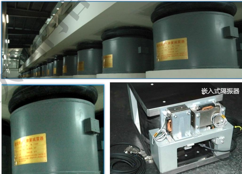
大型/超大型精密隔微振平台与隔振器
