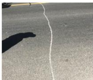
清缝后的裂缝
