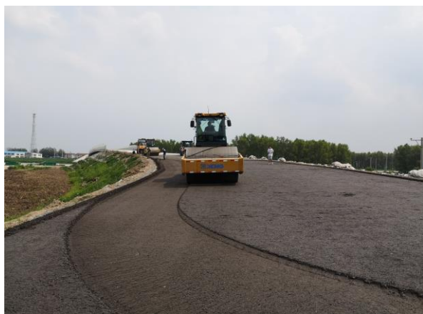
防裂基层材料摊铺和碾压
