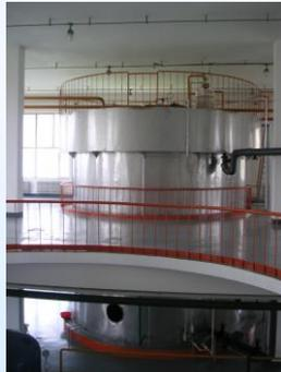
CSTR型发酵生物制氢反应器
