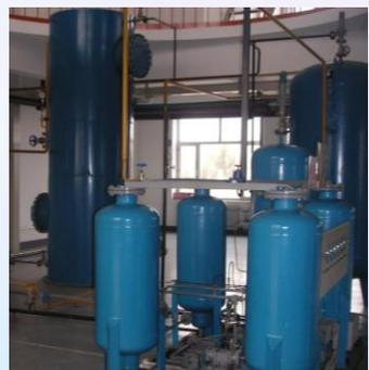
生物制氢示范工程的氢气纯化系统
